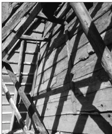
Afb. 9. Brugstraat 20, gepotdekselde wand (rechts) op zolder boven de vloering met linksboven de eiken sporen.
