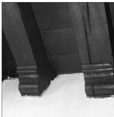
Afb. 7. Oosterstraat 33, detail van de middeleeuwse balklaag boven de begane grond met later toegevoegde 17de-eeuwse consoles. Foto: A. de Goojer, afd. B&M.
