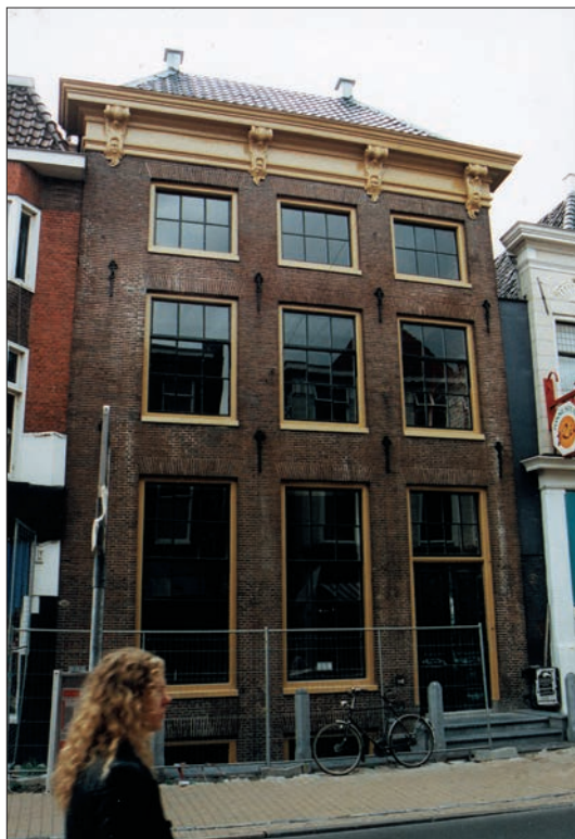
Afb. 7. Oosterstraat 33, voorgevel na restauratie. Foto: gemeente Groningen.
