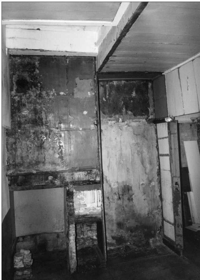
Afb. 9. De stookplaats en de turfstorkoker in de 19de-eeuwse smalle keuken. Foto en tekening: W. Brouwer.
