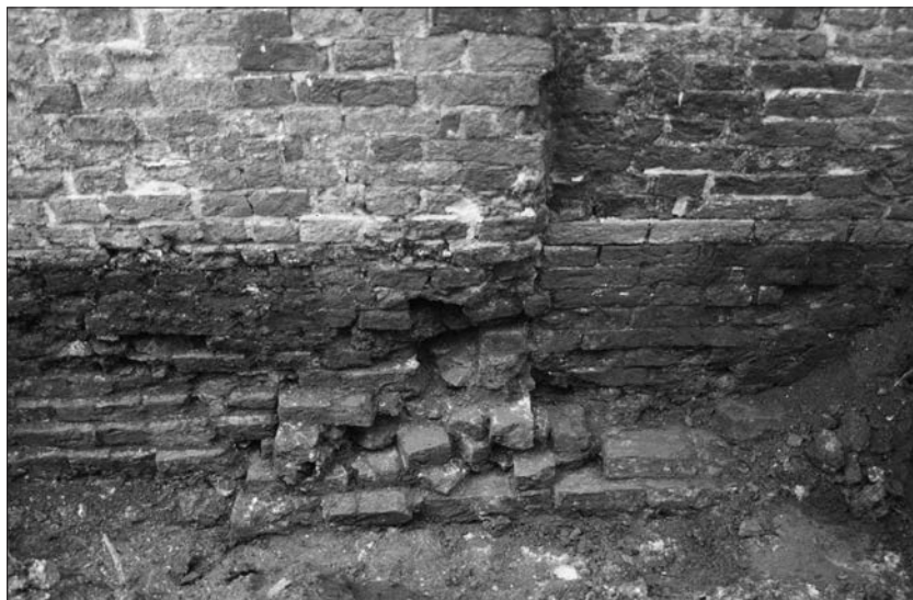
Afb. 2. Fundering, oorspronkelijke oosthoek, met aanhechting van 16de-eeuws koor. Foto: J. v.d. Hoeve.
