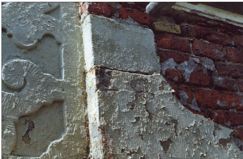
Afb. 5. Zandstenen elementen met vele aangetaste verflagen. Rechts daarvan de van pleister vrijgelegde baksteen. Situatie vóór restauratie. Foto: L. Muller, Zuidhorn.
