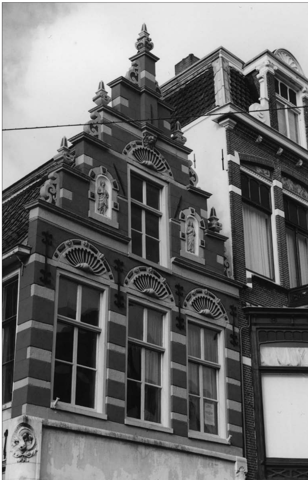
Afb. 7. Bovenste gedeelte van de gevel Oude Ebbingstraat 52 na restauratie. Gedeeltelijk zichtbaar is de nog niet gerestaurerde Jugendstil-onderbouw. Foto: L. Muller, Zuidhorn.
