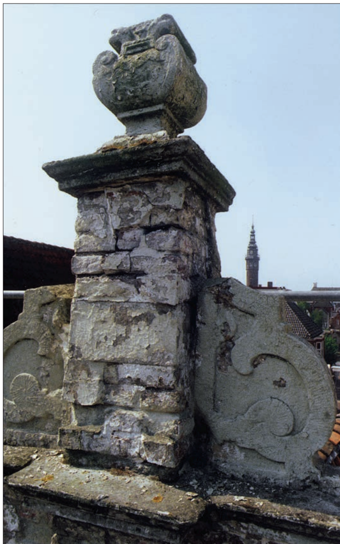
Afb. 4. De top van de trapgevel vóór restauratie. De zandstenen pinakel en de beide rolwerken zijn onvolledig. Het geheel geeft een desolate indruk. Foto: L. Muller, Zuidhorn.
