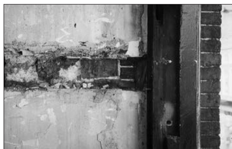
Afb. 2. De kloostermoppen van de oude voorgevel (links) zitten verborgen achter de kleine bakstenen van de 18e-eeuwse gevel (rechts).
