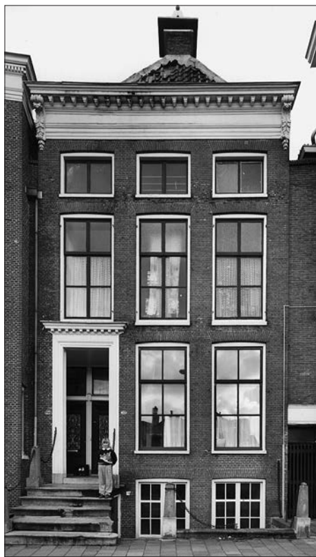
Afb. 1. Voorgevel Hoge der A 18. Foto: Rijksdienst voor de Monumentenzorg.
