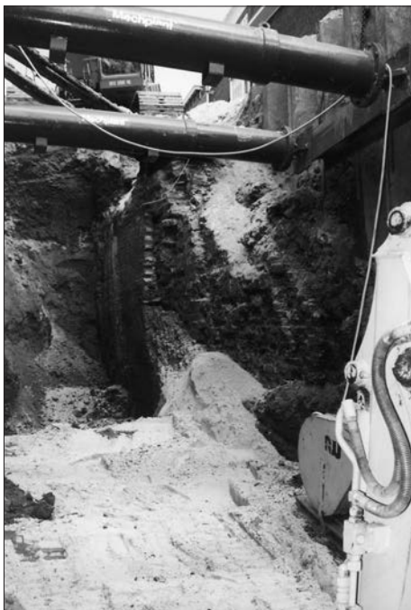
Afb. 3. Overzicht van het zuidelijke landhoofd van de Oosterboog in oostelijke richting. Foto: Dienst RO/EZ.
