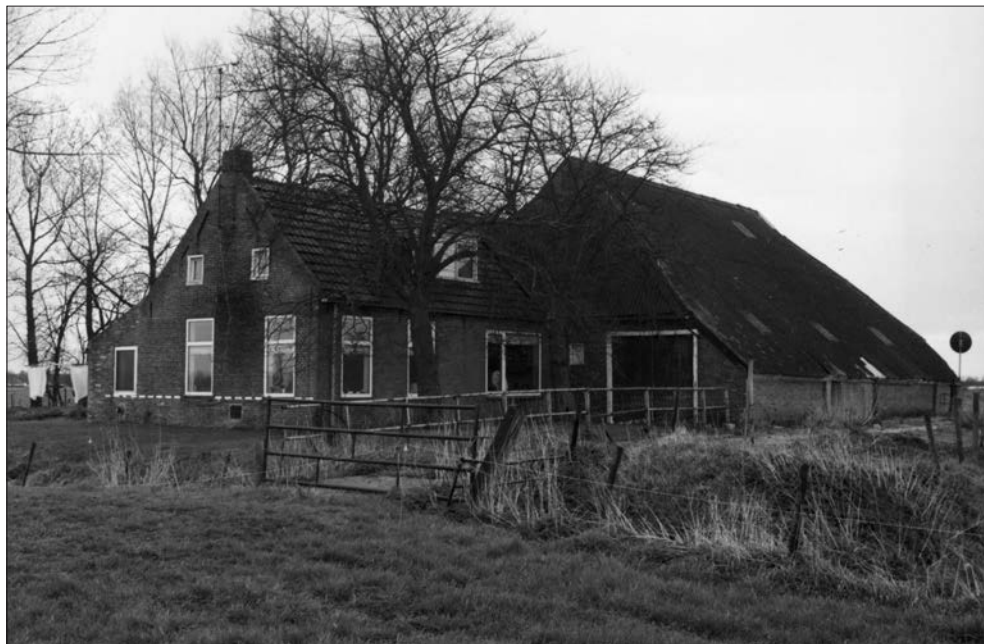
Afb. 10. Voorhuis en schuur van de boerderij Zuiderweg 64 vanuit het noordwesten. Foto: Jan van der Hoeve.
