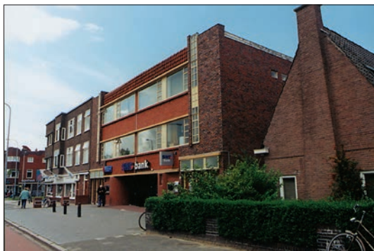
Afb. 15. Korreweg 124-126, woningblok met bankfiliaal na restauratie en kleurherstel. Foto: St. M&M/gemeente Groningen.
