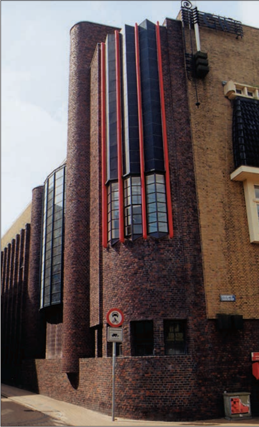
Afb. 11. (links) Ged. Zuiderdiep 96, zijgevel van het hoekpand met teruggebrachte kleuren.
