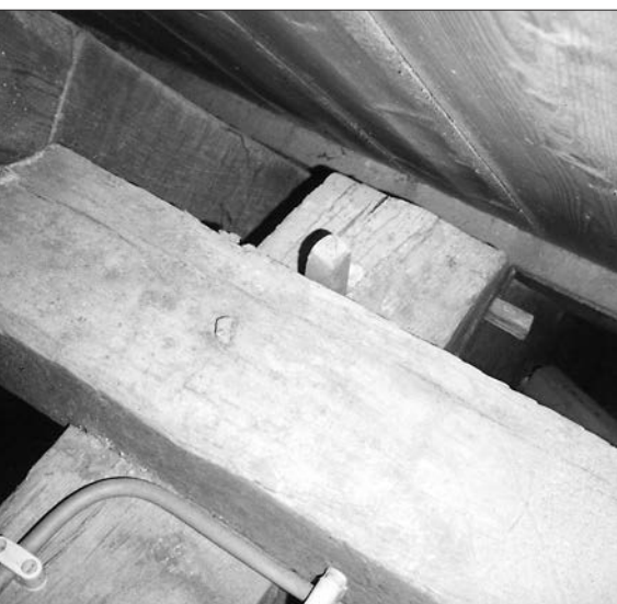
Afb. 6. Detail van de oplegging van de fliering op de dekbalk van een spant, inclusief de houten pen, van boven gezien. Foto: Aletta Bastmeijer.
