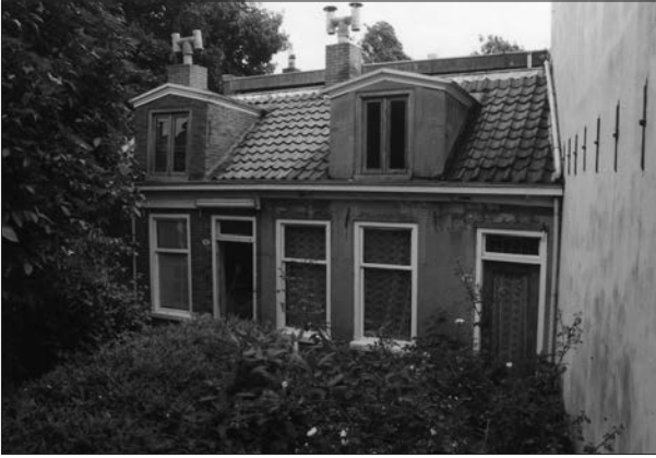
Afb. 2. Voorgevels van Agricolastraat 30 en 32 met de bijbehorende voortuinen. Rechts is de zijgevel van Agricolastraat 34 te zien. Foto: Jan van der Hoeve.
