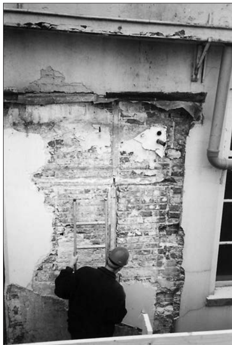
Afb. 14. Zandstenen kruisvenster op de eerste verdieping van de achtergevel van Oude Boteringestraat 43 tijdens de ontleistering. Foto: Sikke-Bart Frieling.
