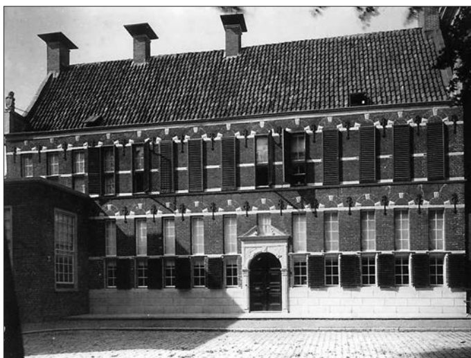
Afb. 11. Voorgevel omstreeks 1910. De oorspronkelijke geveltop is in het midden van de 19e eeuw gesloopt. In de gootlijst bevindt zich een cartouche met de tekst “Ao 1627”. Links op de voorgrond is de vroeg-19e-eeuwse aanbouw zichtbaar, die in 1915 is gesloopt. Foto: Collectie Groninger Archieven.
