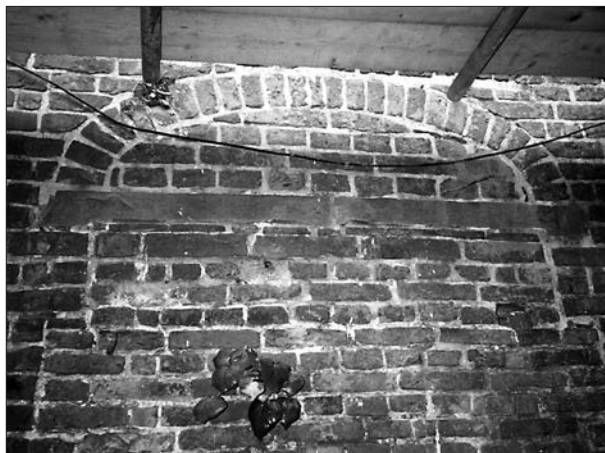
Afb. 4. Westelijke zijgevel, detail van het dichtgemetselde kruisvenster. De bovenzijde van dit venster bestond uit twee zandstenen lateien, waarboven een bakstenen ontlastingsboog.
