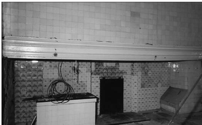
Afb. 7. De 18e-eeuwse schouw in de keuken, 1986. De achterwand van de schouw is betegeld met delfts-blauwe tegels, de boezem met witte tegels. Foto: Lammert Muller (collectie Rijksgebouwendienst).
