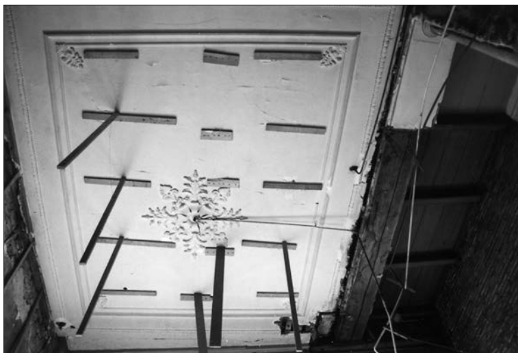
Afb. 10. Stucplafond van de winkel van Oude Ebbingestraat 78 met geprefabriceerde decoraties, 1870. Rechts is de balklaag van de overbouwde gang zichtbaar. Foto: Jan van der Hoeve.
