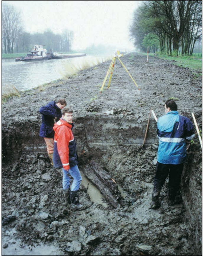
Afb. 21. Van Starckenborghkanaal, fragment van een eiken buis. Foto in noordoostelijke richting. Foto: St. M&M en Dienst RO/EZ.
