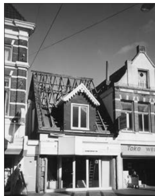
Afb. 22. Nieuwe Ebbingestraat 59, voorgevel tijdens de sloop. Foto: Aletta Bastmeijer.
