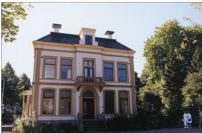
Afb. 19. Zuiderpark 26, na restauratie. Foto: Jaap Buist.
