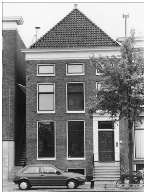
Afb. 8. Hoge der A 9, voorgevel met links de nieuwe trapopgang. Foto: Jaap Buist.
