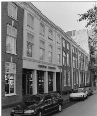
Afb. 4. Gedempte Zuiderdiep 8, voorgevel na verbouw. Foto: Jaap Buist.
