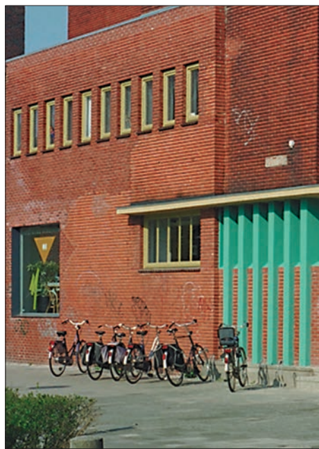
Afb. 15. Noorderbad zuidzijde, na recente verbouw. Foto: DAAD-architecten, Borger.
