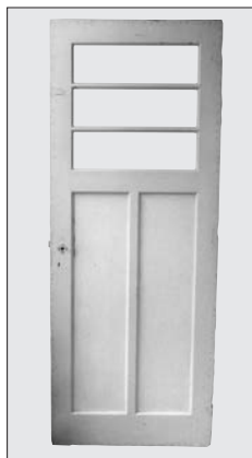
Afb. 4. Niet-Bruynzeeldeur met twee staande panelen en drie ruiten. Foto: Jaap Buist.
