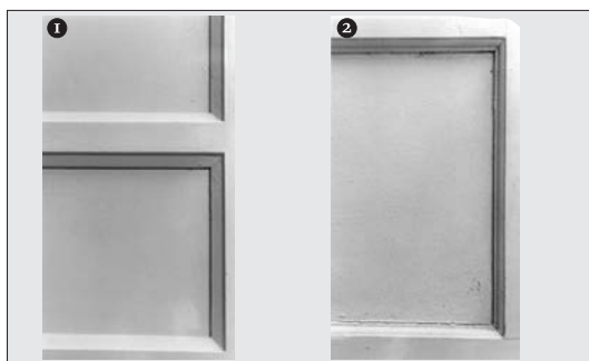
Afb. 3. 1. Bruynzeeldeur met een schuin profiel; 2. Niet-Bruynzeeldeur met een rond profiel. Foto: Jaap Buist.
