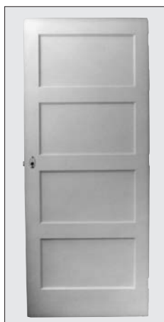
Afb. 7. Bruynzeeldeur met vier liggende panelen uit de tijd van de Wederopbouw. Foto: Jaap Buist.
