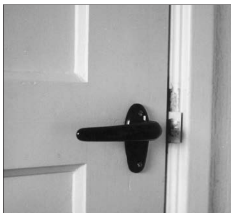
Afb. 14. Deurkruk die geheel uit bakeliet bestaat. Foto: Maria Staal.
