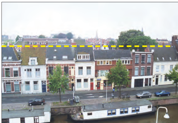
Afb. 28. Turfsingel 29-41, voorgevels. Het oorspronkelijke doorgaande zadeldak, hoewel onderbroken, is duidelijk te herkennen. Foto: Jan van der Hoeve.
