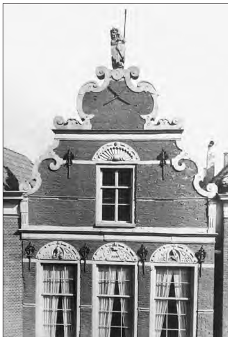
Afb. 2. Gelkingestraat 24, voorgevel vóór de verbouwing van 1896; aan weerszijden van het zoldervenster zijn dichtgezette, smalle luikopeningen te zien. Foto: J.G. Kramer, collectie Groninger Archiven.
