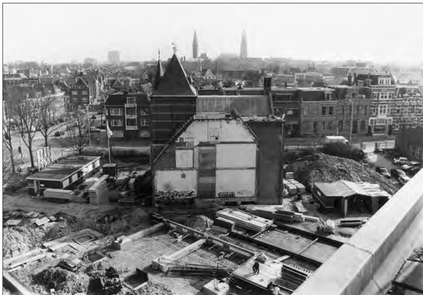
Afb. 9. Westersingel 34, vanaf het dak van Melkweg 1. Foto: Jaap Buist.
