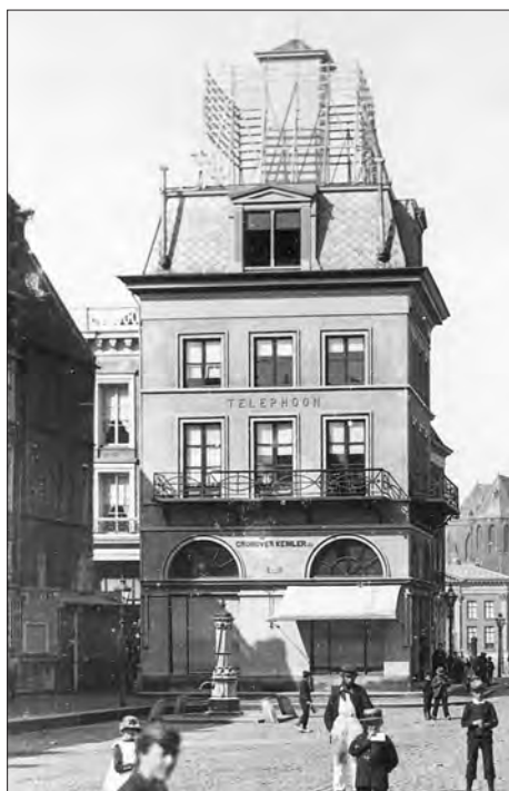
Afb. 4. Grote Markt 51, zicht op het pand naar het westen in circa 1890; op het in 1883 verhoogde dak zijn voorzieningen voor de telefoonmaatschappij Bell zichtbaar.
