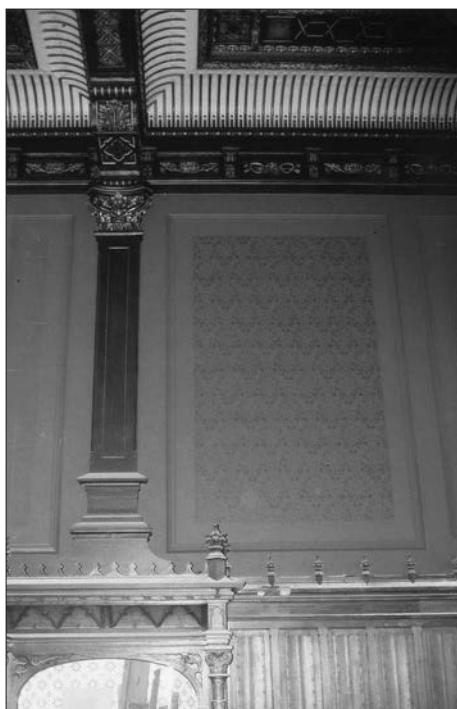
Afb. 18. Stationsplein 4, restauratie wandafwerking van de stationsrestauratie. Foto: Jaap Buist.
