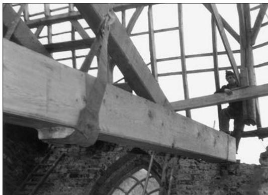
Afb. 12. Legeweg 38, het inbrengen van een nieuwe balk bij de restauratie begin jaren zeventig. Foto: Stichting Groninger Kerken.
