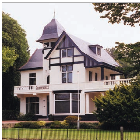
Afb. 20. Verlengde Hereweg 182, na herstel van de oorspronkelijke leisteenbedekking. Foto: Jaap Buist.
