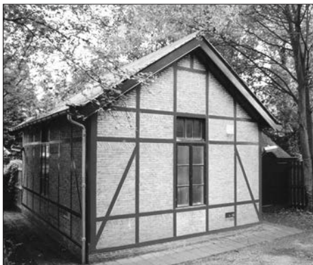
Afb. 8. Grote Rozenstraat 31, het bijgebouw na de restauratie. Foto: Jaap Buist.
