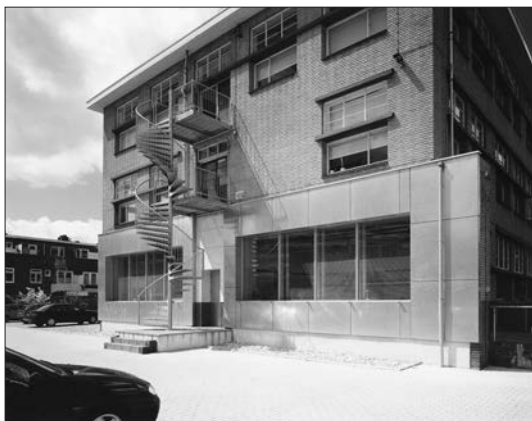
Afb. 10. Hoendiepskade 23/23a, exterieur, aanheling achtergevel na sloop van aanbouw. Foto: SKETS.
