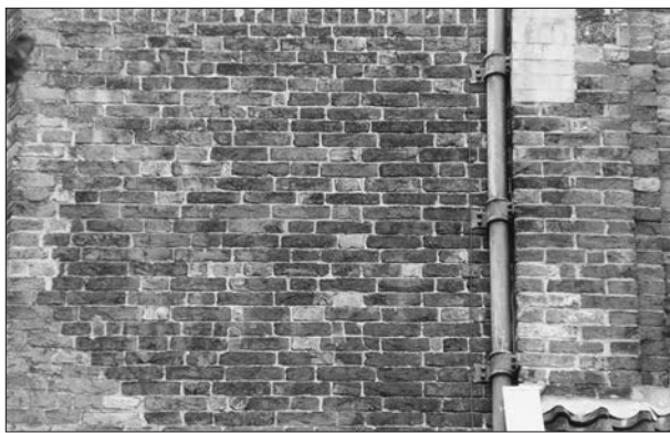
Afb. 6. Oostgevel van de zuidelijke dwarsbeuk van de 13e-eeuwse Akerk, uitgevoerd in noords verband. In het metselwerk zijn relatief veel stenen met glazuur te zien, dat ontstaat door de verhitting van het zout in de klei. Foto: Jan van der Hoeve.
