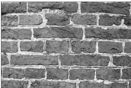
Afb. 11. Zuidgevel van het Pepergasthuis ter hoogte van het Kattendiep, detail van het metselwerk in kruisverband. De voegen hebben een dagstreep, waarin resten van een rode afwerking bewaard zijn gebleven. Foto: Jan van der Hoeve.
