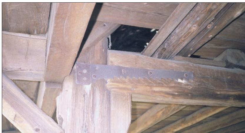
Afb. 13. Vastgenageld zaagblad in loods E. Foto: Jaap Buist.
