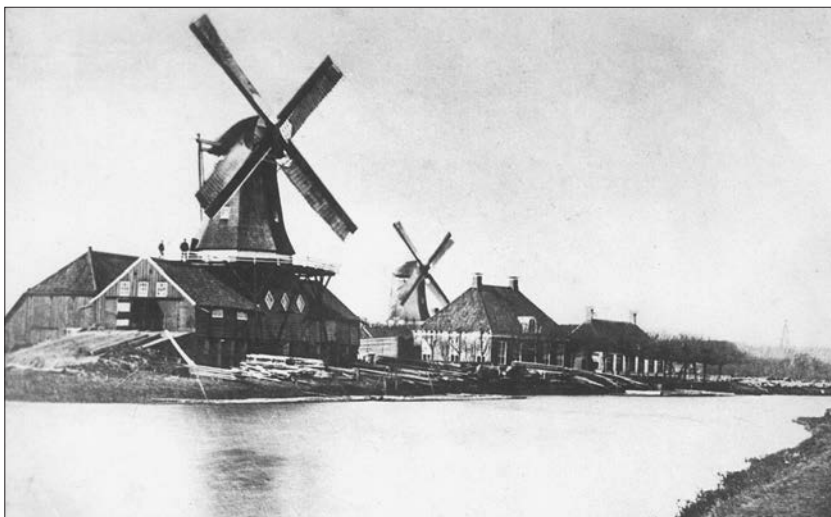
Afb. 4. Zicht op de westelijke oever van het Winschoterdiep met de houtzaagmolen De Vriendschap en daarachter De Zon in circa 1880. Foto: collectie Groninger Archieven.
