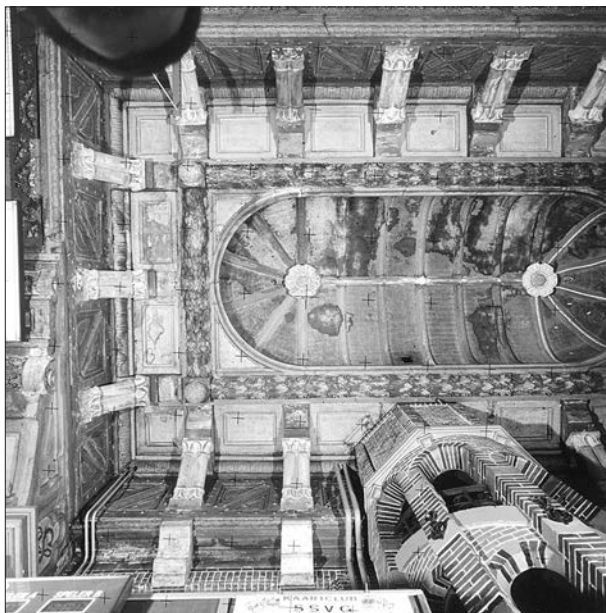
Afb. 2. Tot de grootste boosdoeners van de schade behoorden de vele lekkages die het plafond in de loop der jaren teisterden. Fotogrammetrische opname: ADZ Große Hündfeld.
