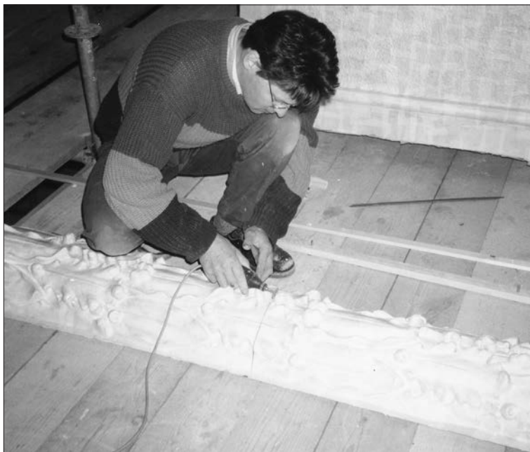
Afb. 5. Een nieuwe eikenbladlijst ondergaat een laatste behandeling voordat de definitieve plaats aan het plafond wordt ingenomen. Foto: Schilderscombinatie Sips/Cor Buist.
