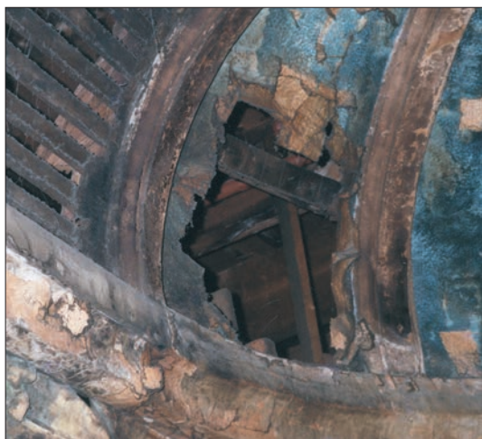
Afb. 3. Op diverse plaatsen was door de afwezigheid van het papierstuc het (nog goede) achterhout zichtbaar.
