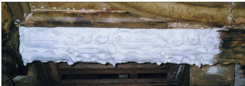
Afb. 6. Een niet meer te herstellen lijst is vervangen door een nieuw element.
