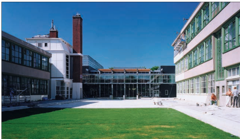
Afb. 7. Binnenterrein met achteraanzicht nieuwbouw en aanbrengen van oorspronkelijke kleurstelling op het monument. Foto: Arthur Blonk.
