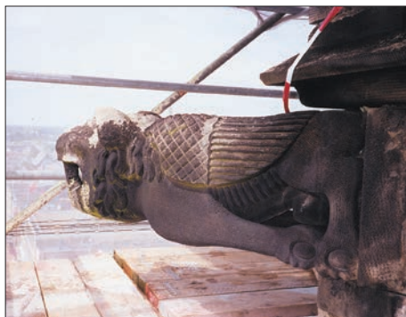
Afb. 7. Martinitoren, onder de eerste trans, spuwer voor de afvoer van hemelwater.
