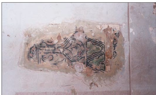
Afb. 16. Stationsplein 4, Hoofdstation, gang in oostvleugel; res- tant imitatietegel-beschildering vóór de overschildering. Foto: Jaap Buist.
