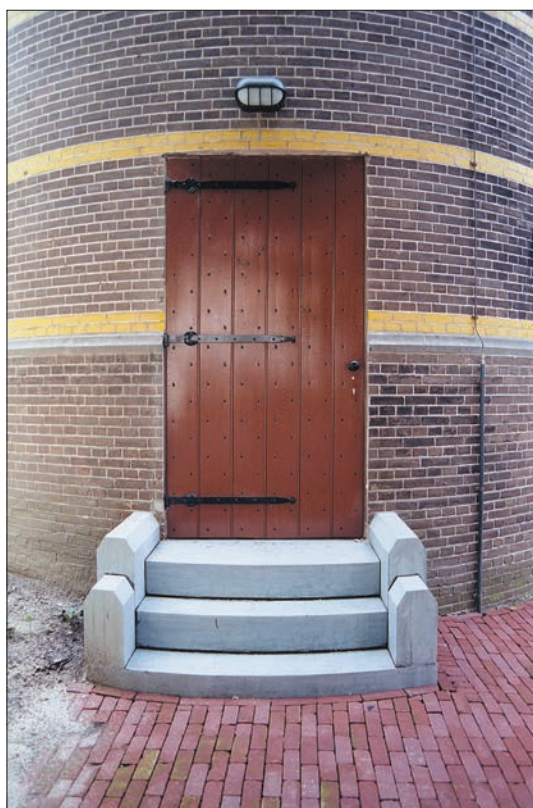
Afb. 10. Vluchtdoor in de gevel van de grote toren. Foto: Jaap Buist.
