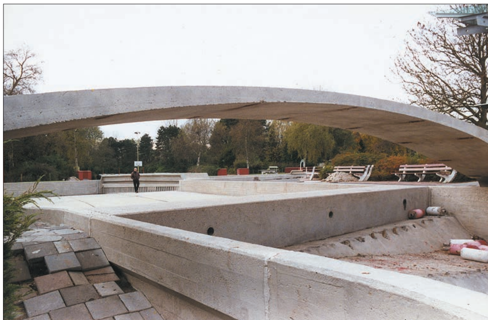
Afb. 9. Eén van de betonnen boogbruggen tijdens de renovatie, 1995. Foto: Rita Overbeek.
