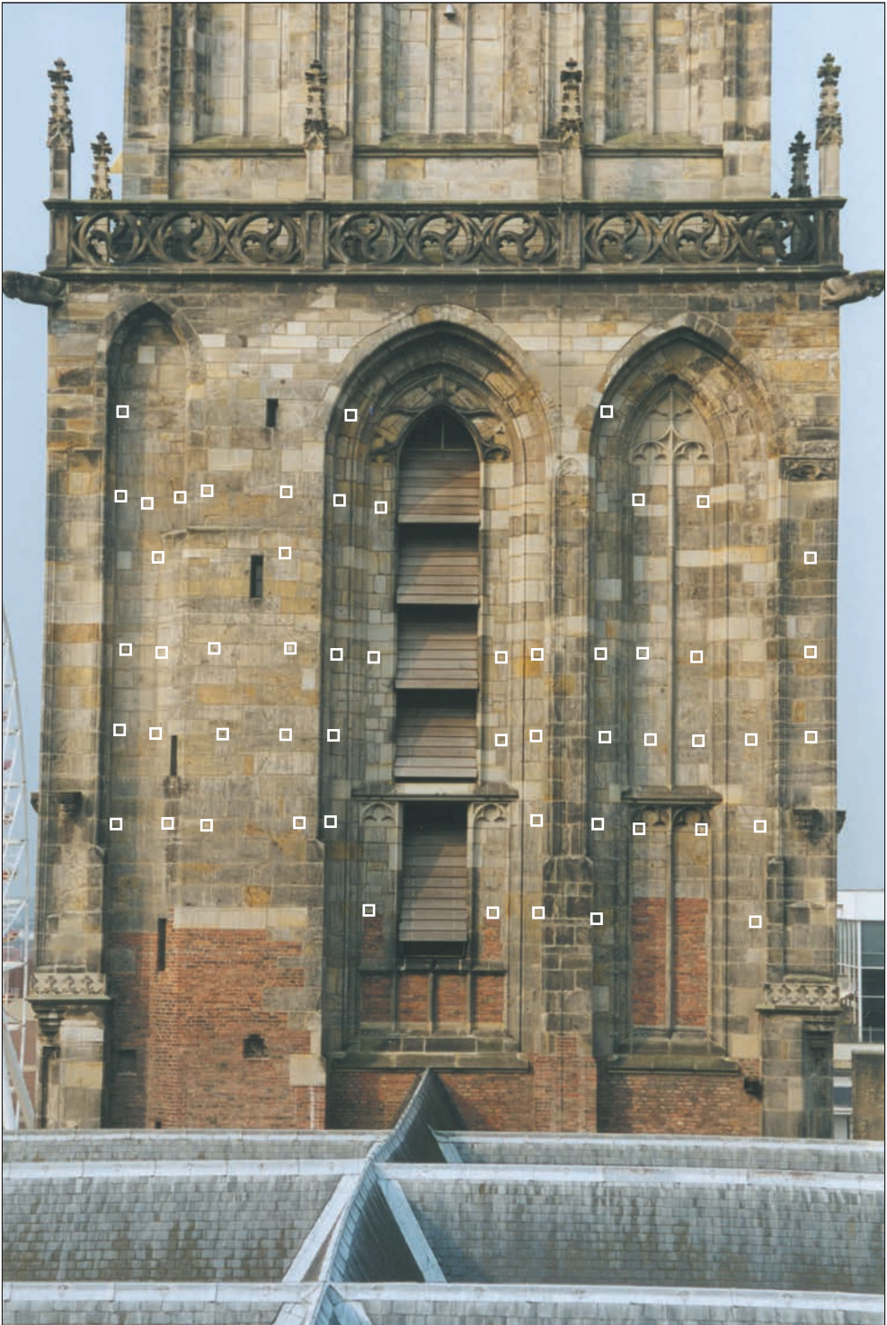
Afb. 5. Oostkant van de tweede geleding met de zandsteenblokjes die de kortelinggaten aangeven. Foto: Taco Tel.
