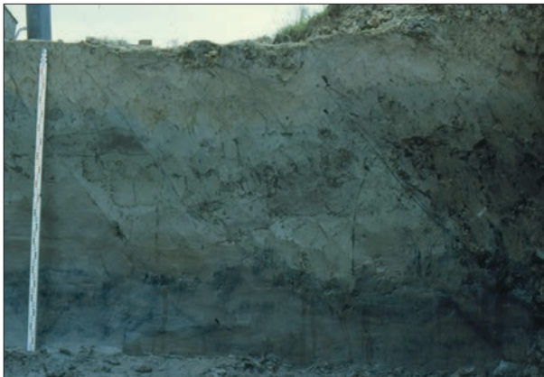
Afb. 9. Hogeweg, detail van de noordelijke coupure door de westelijke Reitdiepdijk. Door afschuiving in oostelijke richting zijn horizontale lagen verschoven. Foto: Henk Nieuwenhuizen.
