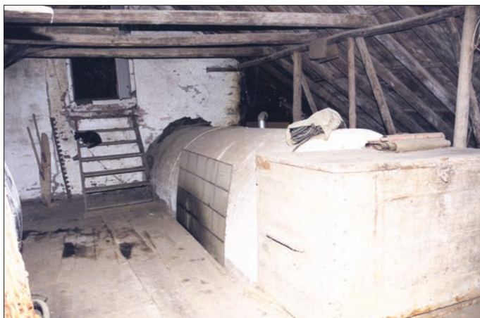
Afb. 26. Westerseweg 2, op de zolder van het tussenlid (tussen voorhuis en schuur) is de stenen overwelfing van de gang zichtbaar. Foto: Aletta Bastmeijer, collectie Dienst RO/EZ.
