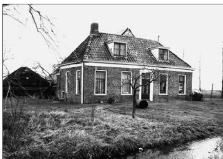
Afb. 22. Legeweg 3, links is de later aangebouwde schuur te zien, 1988. Foto: collectie Dienst RO/EZ.
