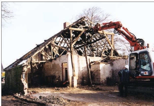
Afb. 24. Peizerweg 158, de balk met inscriptie wordt bij de sloop voorzichtig uit de constructie getrokken. Foto: Jaap Buist.
