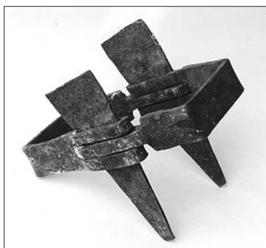
Afb. 4. Kleine Pelsterstraat 5, links: de ijzeren strop die rond een van de spantpalen heeft gezeten; rechts: de ijzeren strop in gedemonteerde toestand. Foto: Taco Tel.
