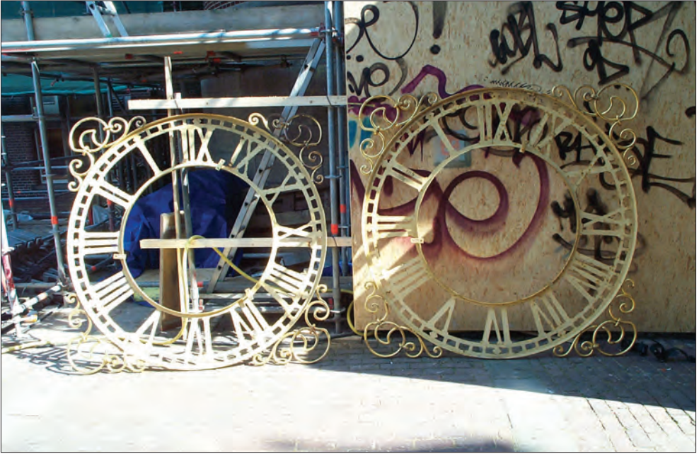
Afb. 6. Broerstraat 5, Academiegebouw, gedemonteerde wijzerplaten tijdens de restauratie. Foto: Aannemingsbedrijf Jurriëns, Groningen.
