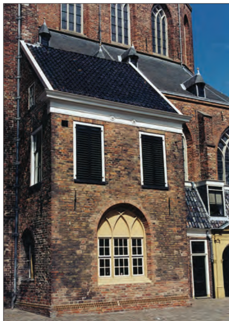
Afb. 2. Akerkhof 2, Der Aa-kerk zuidzijde, opnieuw aangebrachte zonneblinden bij kosterswoning. Foto: Taco Tel.
