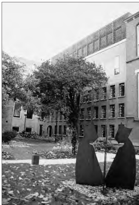
Afb. 19. Oude Boteringestraat 36-38, voormalige rechtbank, optopping archiefgebouw. Foto: Taco Tel.
