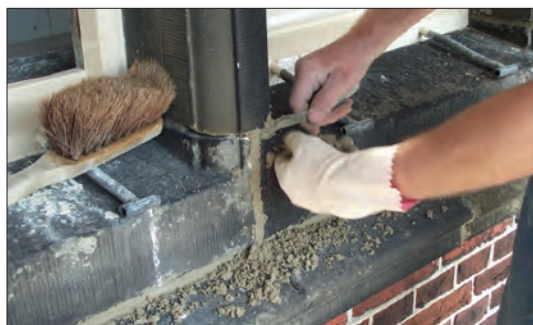
Afb. 4. Broerstraat 5, Academiegebouw, detail zandstenen vensterbank tijdens restauratie. Foto: Aannemingsbedrijf Jurriëns, Groningen.
