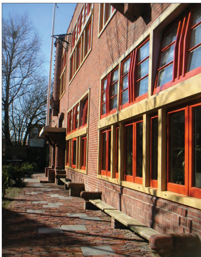
Afb. 4. Voorgevel met de Groninger-rode gevelsteen, na restauratie. Foto: Thon Karelse, Groningen.
