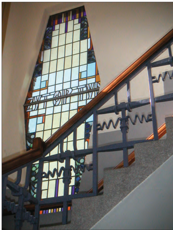
Afb. 2. Trappenhuis met glas-in-loodraam, na restauratie. Foto: Thon Karelse, Groningen.
