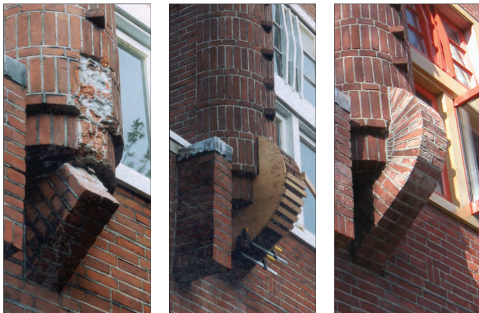
Afb. 3. Herstel van het metselwerk met een formeel (mal). Foto: Thon Karelse, Groningen.
