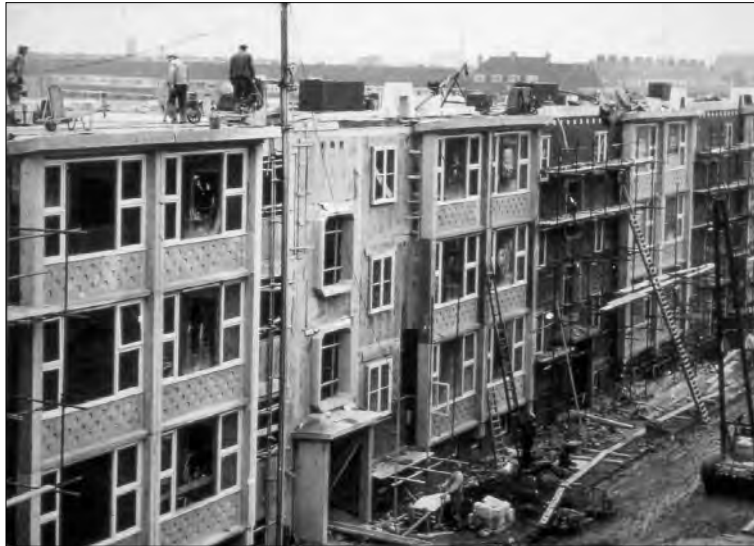
Afb. 8. Systeem Rottinghuis op de bouwplaats. Links zijn de prefab onderdelen zichtbaar en rechts worden deze voorzien van een baksteenbekleding. Foto: P. Boonstra, collectie Dienst RO/EZ.
