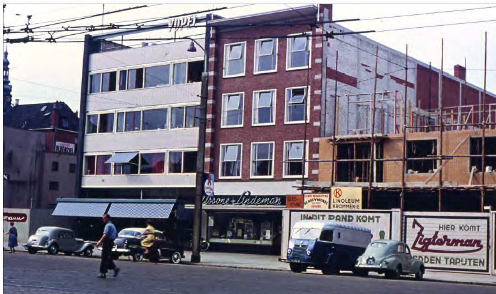
Afb. 2. De noordzijde van de Grote Markt in aanbouw, circa 1954. Foto: collectie Veeger, Dienst RO/EZ.
