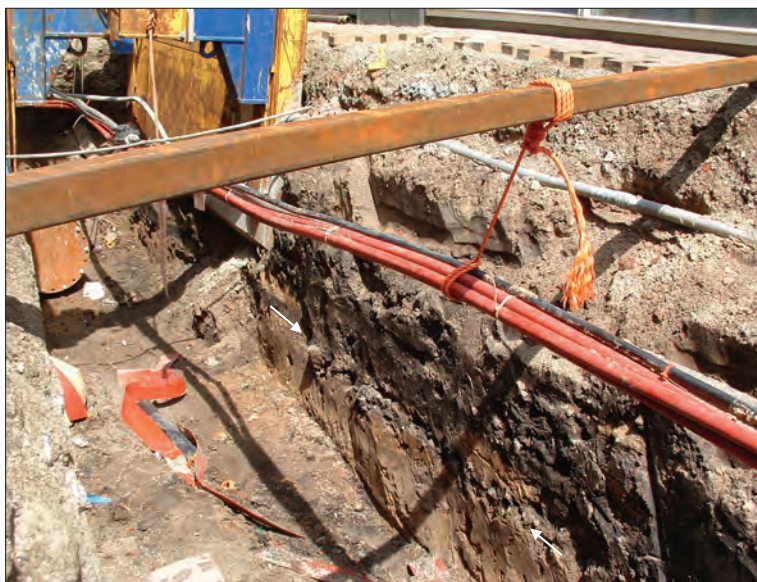
Afb. 15. Pelsterstraat, overzicht van de bouwput voor de reparatie van de gasbuis, gezien in noordelijke richting. Tussen de pijlen bevindt zich de oudste wegverharding. Foto: Gert Kortekaas.
