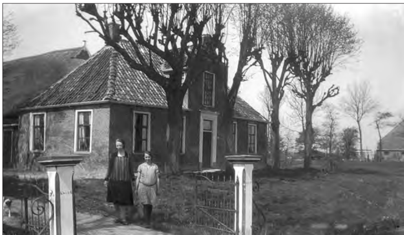
Afb. 2. Aduarderdiepsterweg 14, het voorhuis heeft nog de Vlaamse klokgevel uit 1789 met een groot schuifvenster voorzien van een raam met kleine roedeverdeling, circa 1930.
