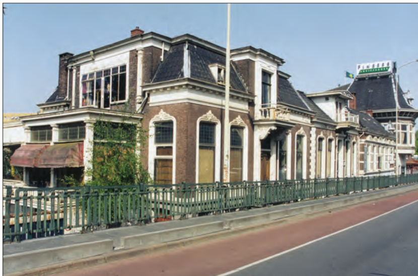
Afb. 14. Hereweg 1-5, voorgevels gezien vanaf het viaduct. Hereweg 5 (links) heeft zeldzame Lucas Ysbrantz-pannen. Foto: Taco Tel.
