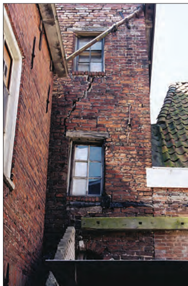
Afb. 7. Gelkingestraat 46, achtergevel van het tweede achterhuis. Links: rondboogvenster met houten diefijzers; rechts: pakhuisvensters van de eerste en tweede verdieping die oorspronkelijk van luiken voorzien waren. Foto: Taco Tel.
