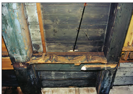
Afb. 20. Poelestraat 28, onderkant van de verdiepingsbalklaag van het voorhuis. Tussen de balken zijn restanten behang bewaard gebleven. Foto: Henk Wierds, collectie Dienst RO/EZ.
