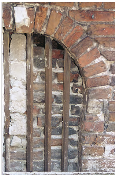
Afb. 7. Gelkingestraat 46, achtergevel van het tweede achterhuis. Links: rondboogvenster met houten diefijzers; rechts: pakhuisvensters van de eerste en tweede verdieping die oorspronkelijk van luiken voorzien waren. Foto: Taco Tel.
