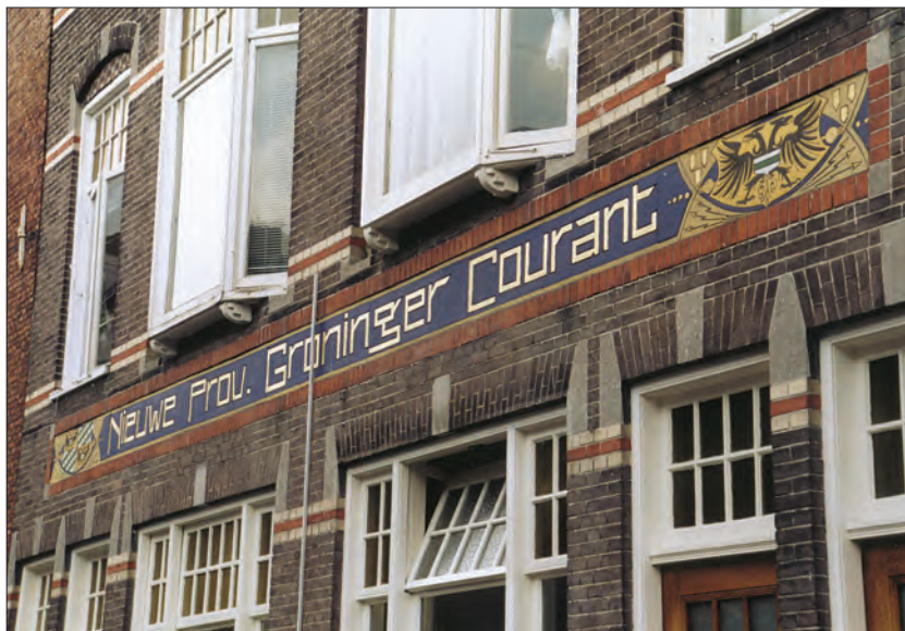
Afb. 30. Wipstraat 10-12, na restauratie van het tableau. Foto: Taco Tel.
