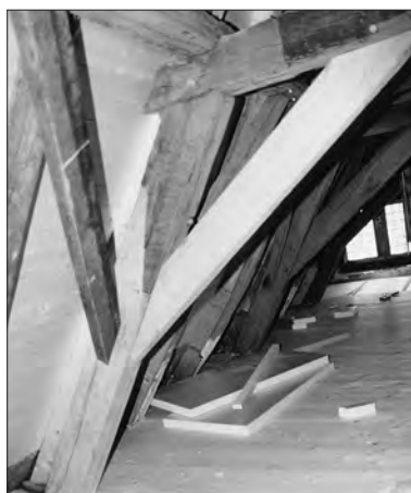
Afb. 21. Oude Boteringestraat 27, zorgvuldig hersteld spantbeen. Foto: Taco Tel.
