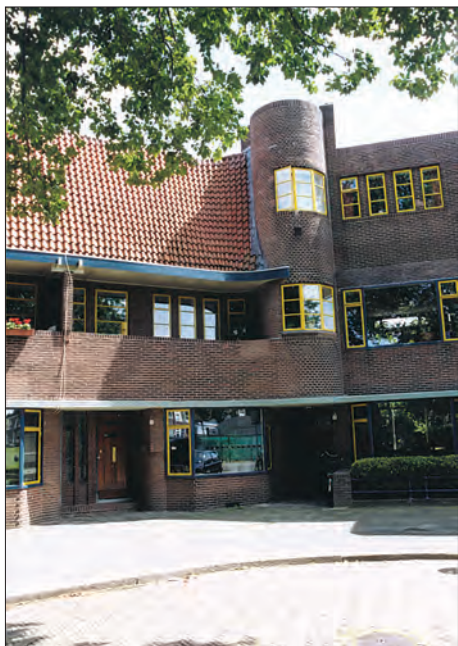
Afb. 2. Bernoulliplein 26 en 28, voorzijde na restauratie. Foto: Imre van der Gaag, collectie Dienst RO/EZ.
