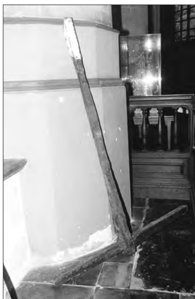
Afb. 15. Martinikerkhof 3, het verwijderde gedeelte van de trekstang. Foto: Taco Tel.
