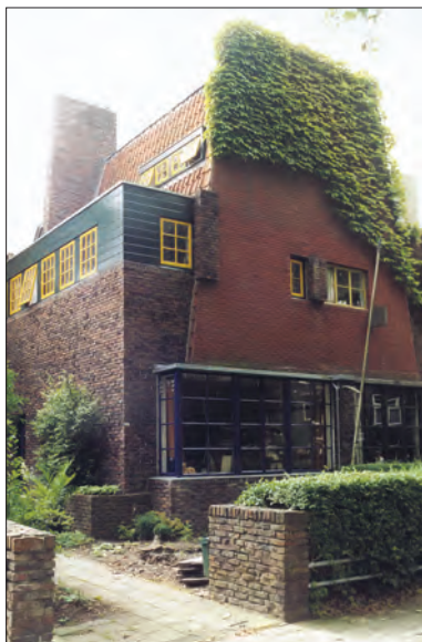
Afb. 17. Nassaulaan 6, na kleurherstel.
