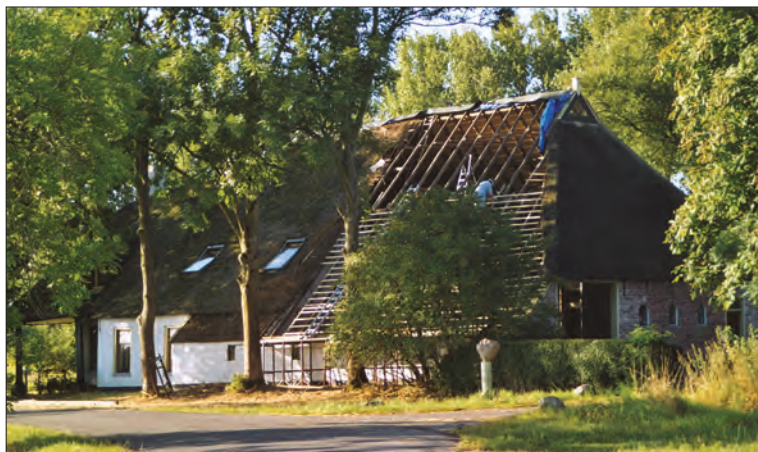
Afb. 24. Paddepoelsterweg 11 noordzijde, het vernieuwen van het rieten dak, 2003. Foto: Taco Tel.
