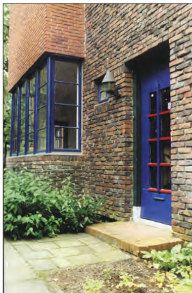
Afb. 18. Nassaulaan 6, na kleurherstel.
