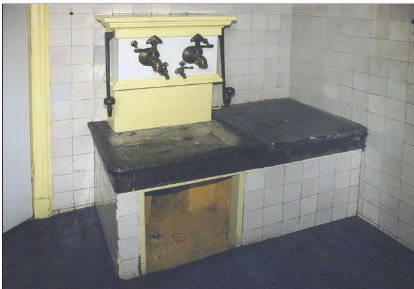
Afb. 10. De 18e-eeuwse gootsteen met pomp en koperen kranen, afkomstig uit het oude, in 1838 afgebroken, molenaarshuis. Foto: Taco Tel.
