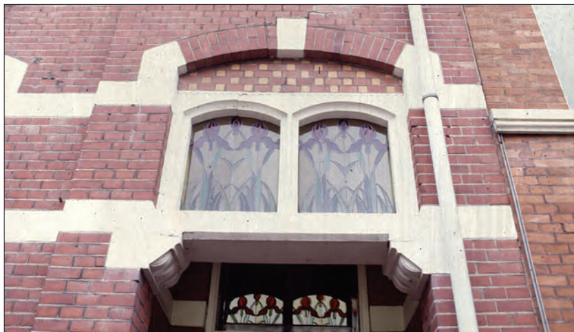
Afb. 6. Turfsingel 75, glas-in-loodvensters in de portiek en boven de voordeur, vlak voor de sloop. Foto: Aart de Goojer, collectie M&M.
