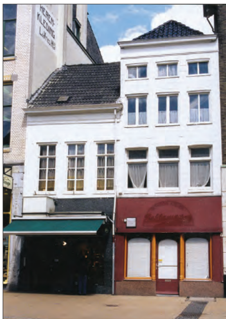
Afb. 4a. Brugstraat 3 (rechts) en 5, vóór de verbouw en restauratie van het rechterpand. De gietijzeren zuilen, waarvan delen ter weerszijden van de deur zichtbaar zijn, horen bij een 19e-eeuwse pui die grotendeels achter de moderne beplating schuil ging. Foto: Taco Tel.
