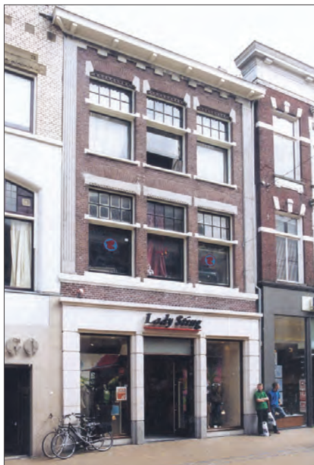
Afb. 16. Herestraat 22, foto van de voorgevel. Foto: Taco Tel.
