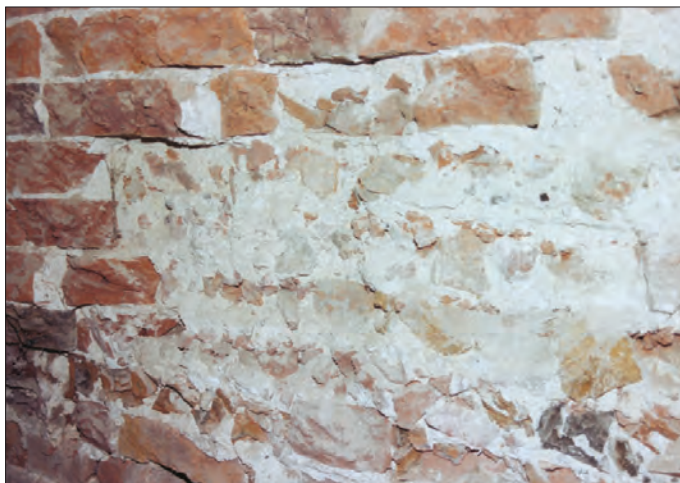
Afb. 17. Herestraat 25, muur van de zijgevel op de begane grond met betonachtige mortel en steenbrokken, gebruikt als vulling van het kistwerk. Foto: Imre van der Gaag, collectie Dienst RO/EZ.
