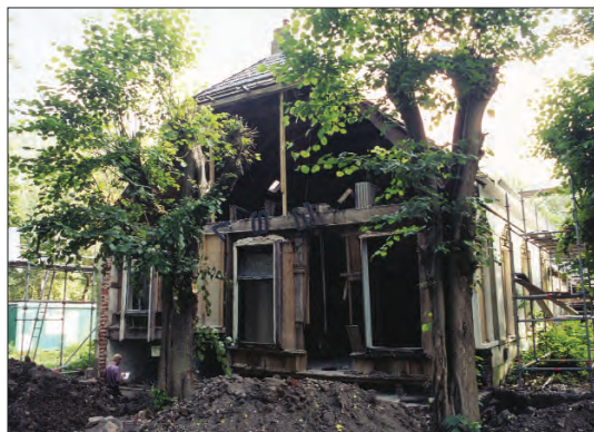
Afb. 16. Noorddijkerweg 31, voorgevel voorhuis tijdens de ingrijpende restauratie. Foto: Henk Wierds, collectie Dienst RO/EZ.
