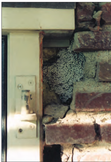
Afb. 24. Turfsingel 64 t/m 74, opengelegd muurwerk tijdens de herstelwerkzaamheden. Foto: Taco Tel.
