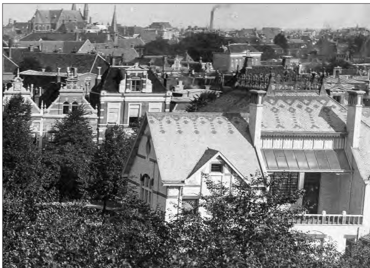
Afb. 30. Ubbo Emmiussingel 110, duidelijk zichtbaar de oorspronkelijke patronen in de leibedekking. Foto: collectie RHC Groninger Archieven.
