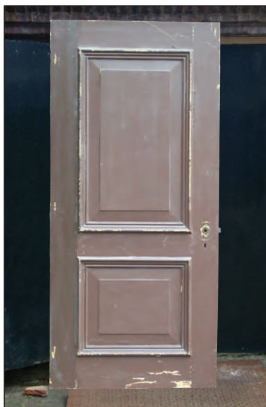
Afb. 7. Gangzijde met twee panelen van de werkkamerdeur van jhr. mr. J.A. Feith uit het Feithhuis, 19e eeuw; maten 219 × 101 × 4 cm. Bijzonderheden deur: panelen bossing, profiel ojief met kraal en opgelegd profiel, regel vuren en knieren. Foto: Arjan Verschoor.
