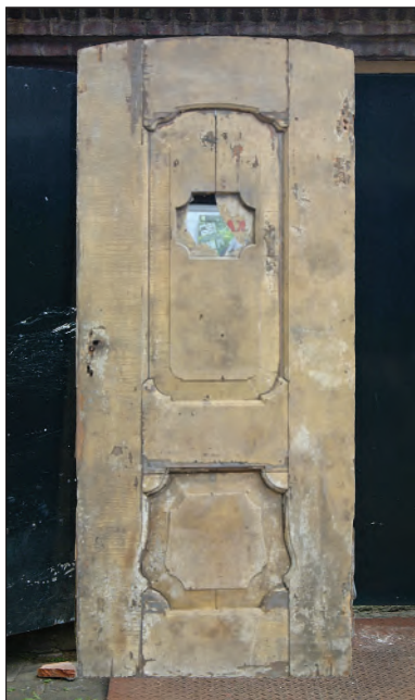
Afb. 11. Grenen 18e-eeuwse tweepaneeldeur uit de Oosterstraat 67, maten 208 × 91 × 4,1 cm. Bijzonderheden deur: bovenkant getoogd, panelen aan beide zijden met brede bossing, paneel gecontourneerd, profiel kwartrond, gesloten pengatverbinding en knieren. Foto: Arjan Verschoor.
