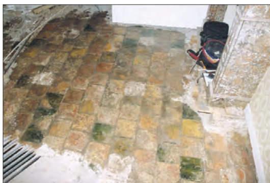
Afb. 27. Marktstraat 19, de plavuizen ondervloer na verwijdering van de houten vloer. Foto: Taco Tel.
