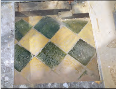
Afb. 36. Vismarkt 56, de 17e-eeuwse plavuizenvloer op de verdieping van het voorhuis. Foto: Taco Tel.
