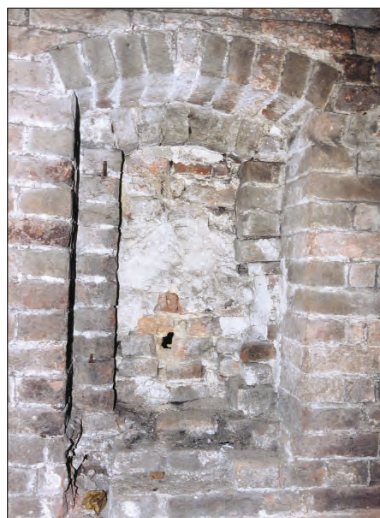
Afb. 32. Vismarkt 56, de binnenkant van het luikvenster op de zolder van het voorhuis met links in de terugliggende dagkant twee ijzeren duimen waaraan een luik heeft gehangen.
