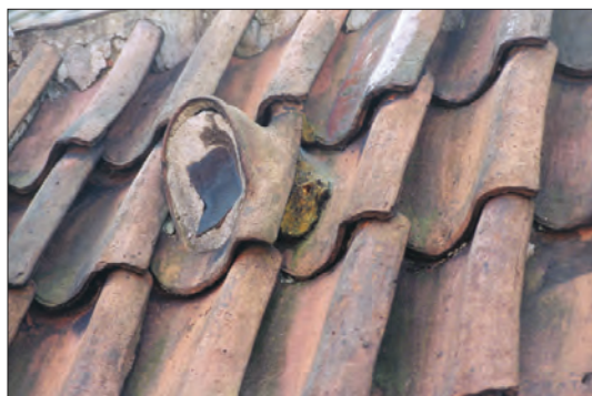
Afb. 7. Akerkhof 41, de panbedekking voor de renovatie, 2004. Op het dak ligt een zeldzame uilenpan. Oorspronkelijk was het gat waarschijnlijk voorzien van een ruitje ter verlichting van de zolder. Foto: Taco Tel.
