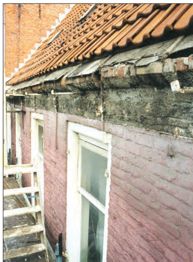
Afb. 14b. Gelkingestraat 20, detailopname van de voorgevel, zichtbaar de originele gevelbeëindiging met zandstenen blokken. Foto: Taco Tel.
