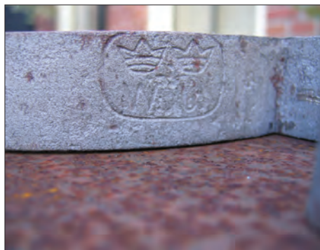
Afb. 33. Westersingel/Verlengde Visserstraat, detail oorspronkelijke hekstaaf, met merk van de producent die het ijzer geleverd heeft. Foto: Ron Caspers. Warffum.
