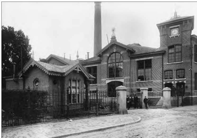
Afb. 11. Bloemstraat 38, historische foto van de ingang van de Gemeentelijke Lichtfabrieken, augustus 1916. Foto: P.B. Kramer, collectie RHC Groninger Archieven.
