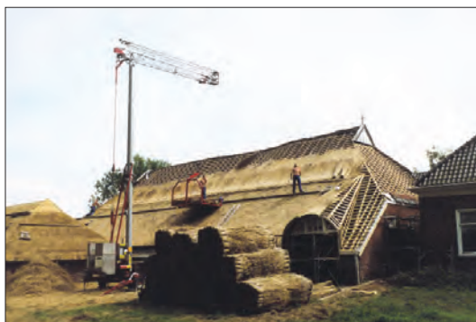
Afb. 22. Noorddijkerweg 22, de vernieuwing van het rietendak van hoofd- en bijschuur, 2005. Foto: Marcel Verkerk.
