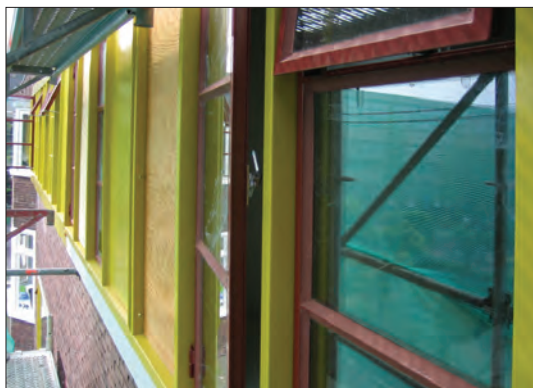
Afb. 9. Bernoulliplein zuidzijde tijdens de restauratie.
