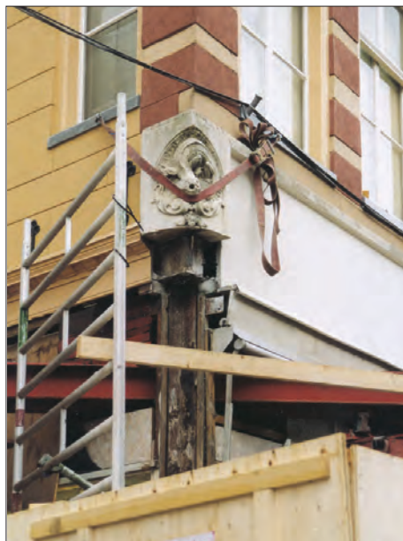
Afb. 24. Oude Ebbingestraat 52, verwijderde natuurstenen kolom tijdens herstel. Foto: Taco Tel.
