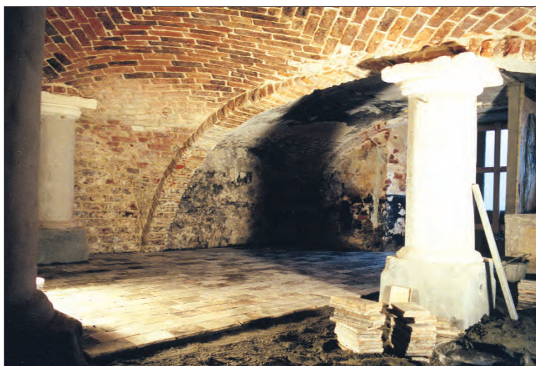
Afb. 18. Hoge der A 17, middeleeuwse kelder in het voorhuis tijdens herstelwerkzaamheden, met de recent toegevoegde zuilen. Foto: Marcel Verkerk.
