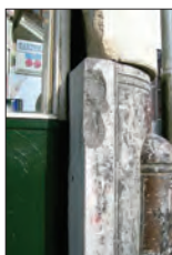
Afb. 23. Oude Ebbingestraat 52, beschadiging natuursteen na aanrijding. Foto: Veenstra Natuursteen BV, Uithuizermeeden.
