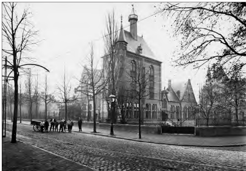
Afb. 31. Westersingel/Verlengde Visserstraat, de hekwerken met op de achtergrond het Natuurkundig Laboratorium begin vorige eeuw. Foto: collectie RHC Groninger Archieven.
