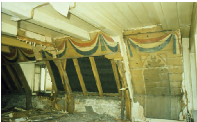
Afb. 1. Geschilderde draperie met venster, zoals die in 1990 op de zolder achter het behangsel werd aangetroffen. Foto: onbekend.
