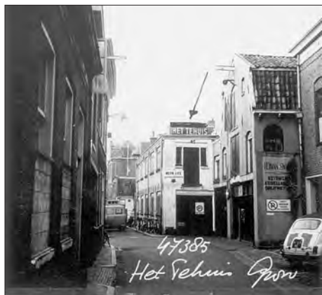
Afb. 4. Lutkenieuwstraat 11 vóór 1970, gezien naar het noorden. Foto: collectie Stichting M&M.
