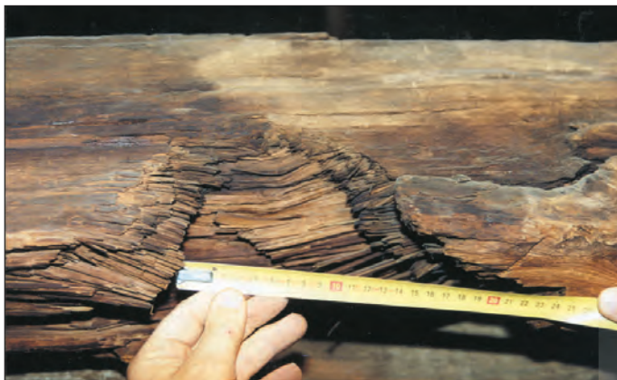
Afb. 19. Gelkingestraat 48. Het rafelige gat in het spant van het voorhuis, veroorzaakt door een kanonskogel. Foto: Taco Tel, collectie Dienst RO/EZ.
