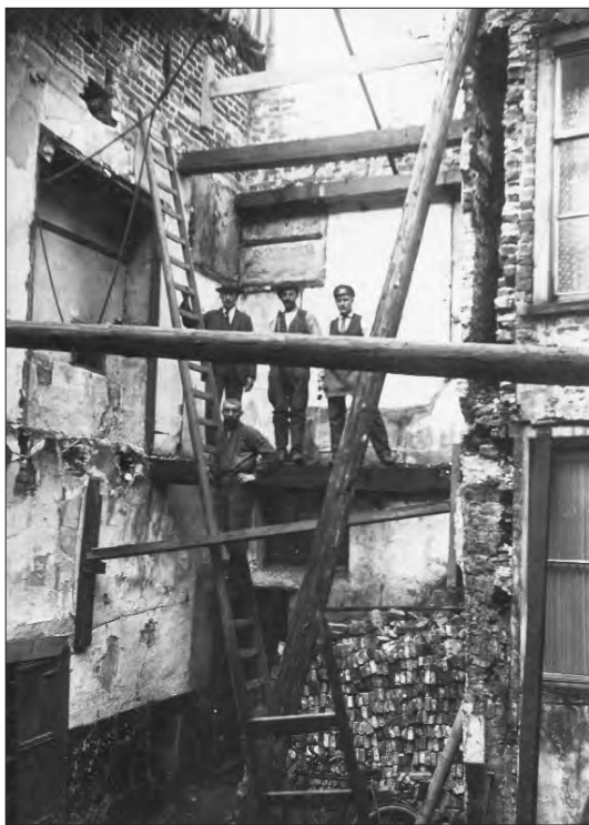
Afb. 28. Herestraat 13 in 1924 (links op de foto) tijdens de sloop van de aanbouw ten behoeve van de bouw van een nieuw pakhuis in 1924. De slopers moesten grote moeite doen om de noordgevel van Herestraat 17 overeind te houden. Foto: collectie RHC Groninger Archieven.
