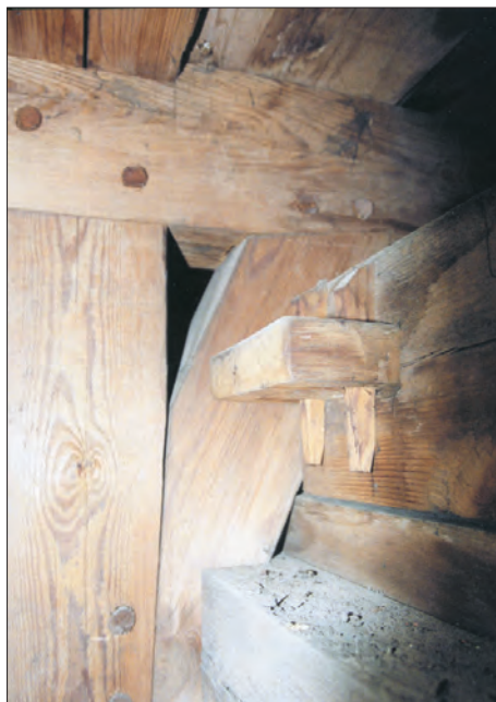
Afb. 22. Grote Markt 1, de binnenkant van de kroonlijst, twee houten wigvormige pennen klemmen de mutulus vast.
