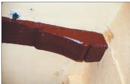
Afb. 14. Gelkingestraat 10, console onder de zolderbalklaag. Foto: Taco Tel, collectie Dienst RO/EZ.
