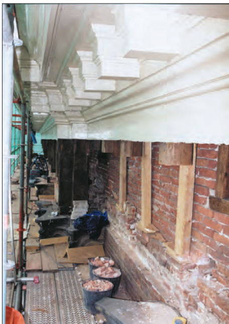
Afb. 21. Grote Markt 1, na verwijdering van een groot deel van de kroonlijst kwam de achterliggende constructie naar voren. De kapitelen zijn onderaan de foto zichtbaar.
