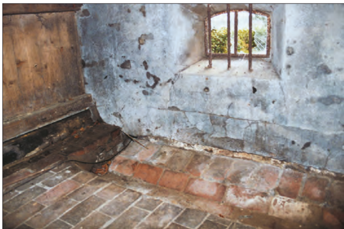
Afb. 11. Friesestraatweg 251, detail bestrating koegang, gezien vanaf de grup; onder de dwarsgeplaatste stenen op z'n kant ligt de goot voor de gier die vanuit de paardenstal wordt afgevoerd naar de koegrup.
