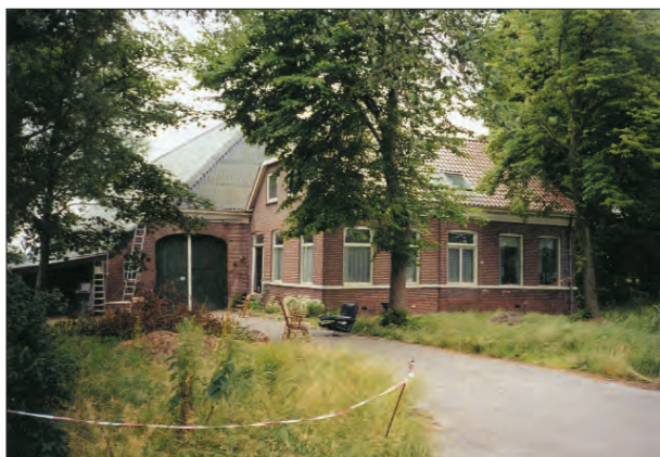
Afb. 37. Roderwolderdijk 9, voor- en zijgevel.
