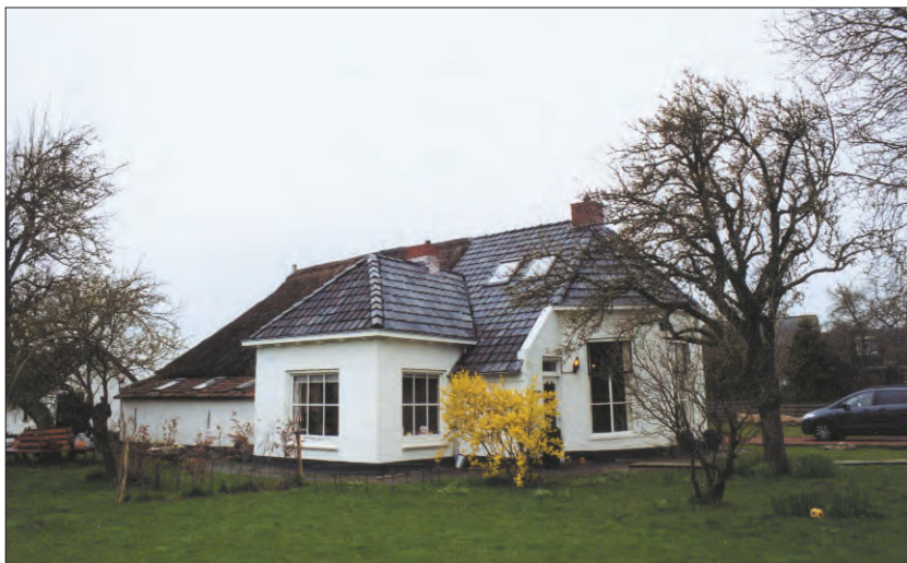
Afb. 2. Aduarderdiepsterweg 10, overzicht voor- en linkerzijgevel. Foto: Marcel Verkerk, collectie Dienst RO/EZ.
