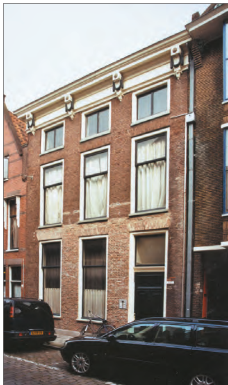
Afb. 41. Turftorenstraat 7, voorgevel na vernieuwing van het onderste deel van het metselwerk. Foto: Taco Tel, collectie Dienst RO/EZ.
