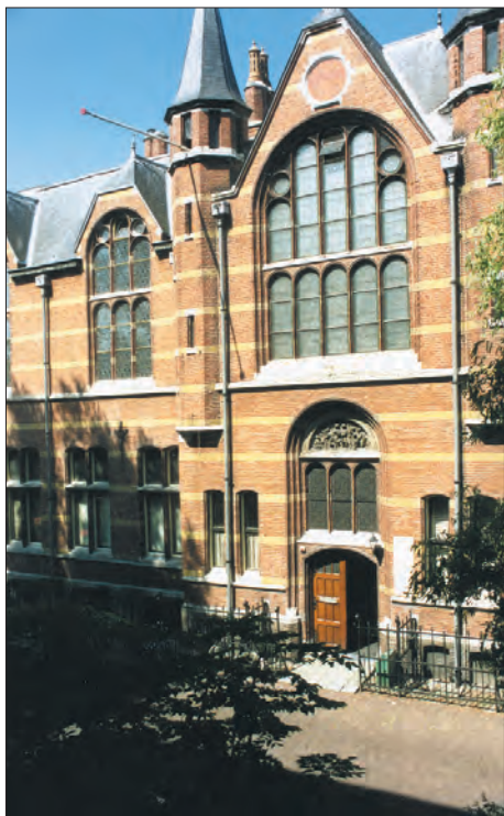
Afb. 8. Grote Rozenstraat 31, voormalig Botanisch Laboratorium, gevel aan de straatzijde. Foto: collectie Dienst RO/EZ.
