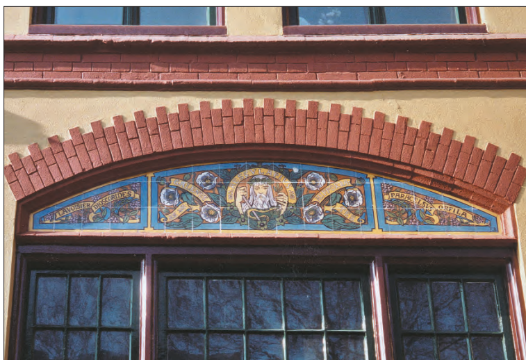
Afb. 37. Zuiderpark 18, het tegeltableau na reiniging en kleurherstel van de gevel.
