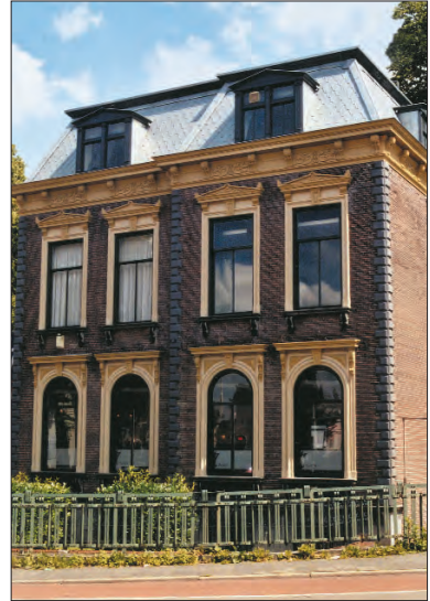
Afb. 21. Parklaan 1, na aanbrengen van de nieuwe losagnes. Foto: Berend Raangs, collectie Dienst RO/EZ.
