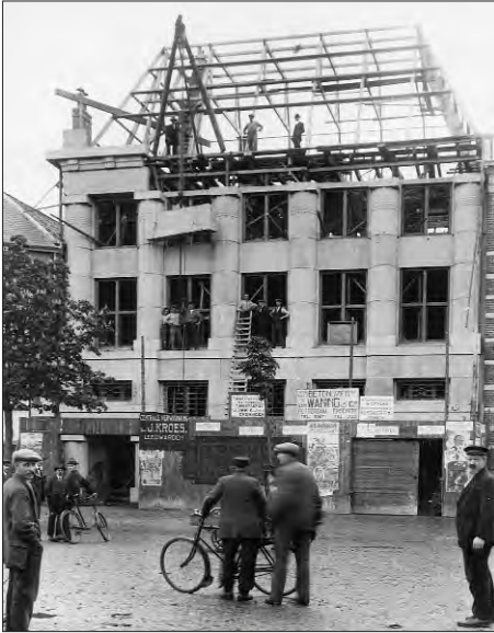
Afb. 32. Vismarkt 54, tijdens de bouw in 1923-1924. Foto: collectie RHC Groninger Archieven.
