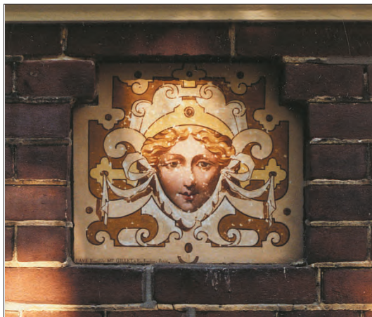
Afb. 29. Ubbo Emmius singel 23, geëmailleerde lavasteen na schoonmaken, met linksonder naam producent. Foto: Berend Raangs, collectie Dienst RO/EZ.
