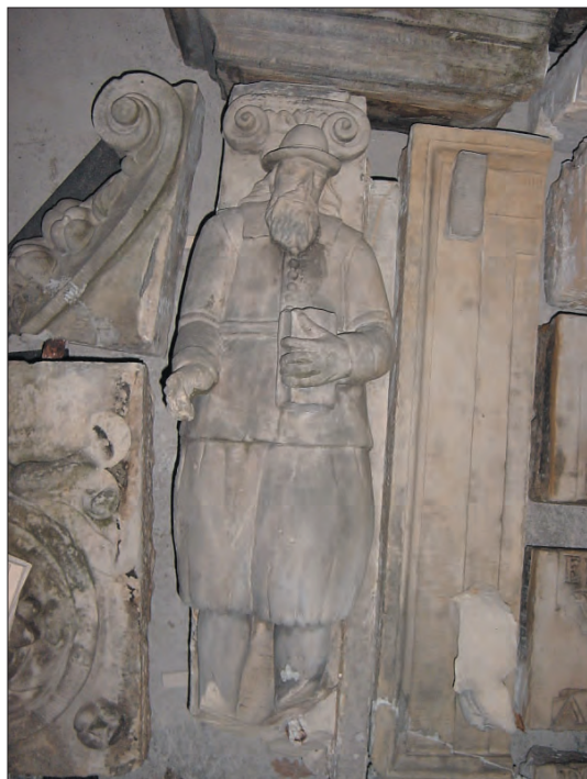
Afb. 25. Rademarkt 29, gedemonteerde gehavende natuursteen onderdelen van de poort. Foto: OVT architecten, Groningen.
