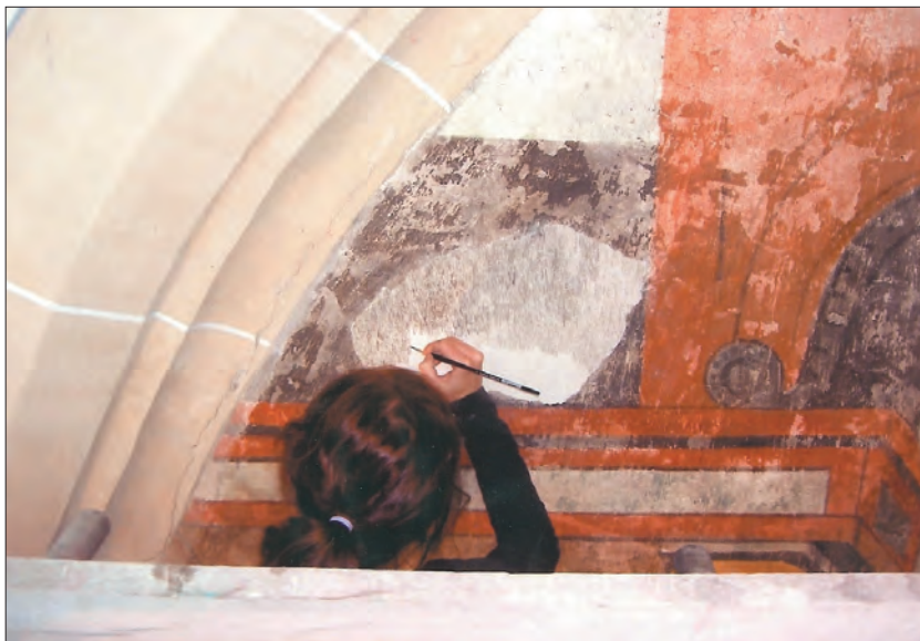
Afb. 5. Martinikerk, hoogkoor, kleurreconstructie op een nieuw ingepleisterd vlak door middel van het aanbrengen van een arcering. Uit rapport 'De Manenstegell BV' (2), 2006, 47.
