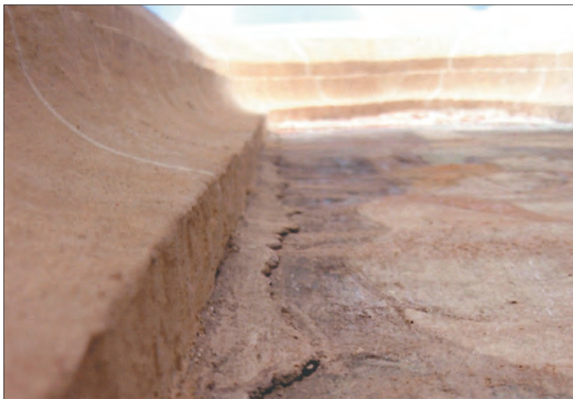
Afb. 4. Martinikerk, hoogkoor, ten opzichte van de secco's verhoogd gelegen pleisterwerk. Het betreft herstelwerk van vóór 1923, uit de periode dat de secco's nog onder een dikke laag witkalk schuilgingen. Uit rapport 'De Manenstegell BV' (2), 2006, 44.
