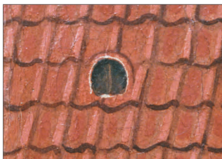
Afb. 4. Detail van afb. 1 met uilenpan op het zuidelijke dakvlak van Lutkenieuwstraat 9.
