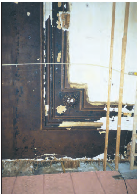
Afd. 13. Rozet van het plafond uit de grote bovenzaal. De rozet kwam tevoorschijn bij het bouwhistorisch onderzoek van het zalencomplex in 2006. Foto: Taco Tel, collectie Dienst RO/EZ.
