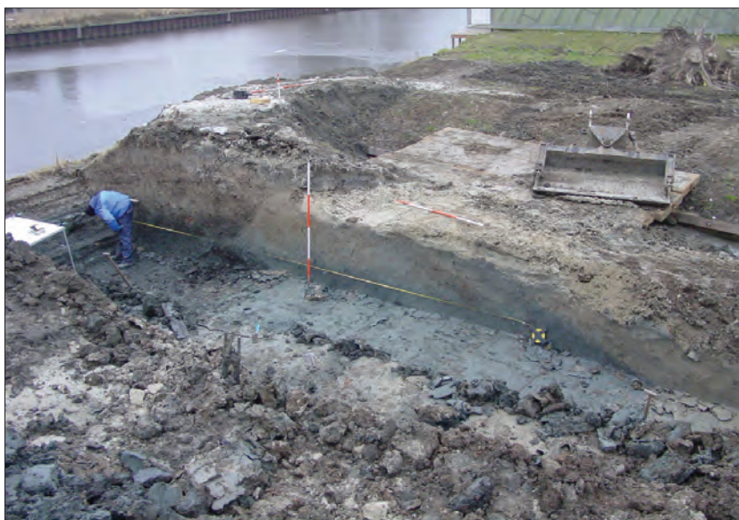
Afb. 47. Reitdiepdijk, Grote Beerstraat, doorsnede door de Reitdiepdijk gezien in noordwestelijke richting.
