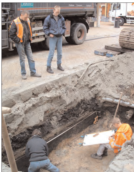
Afb. 48. Stoeldraaierstraat, in de wand aan de straatzijde tekent zich op het donkere esdek een lichtere zandlaag af: de onderlaag van een wegdek. Foto: Gert Kortekaas, collectie Dienst RO/EZ.
