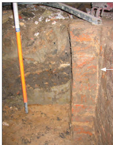
Afb. 26. Gelkingestraat 46-48, opvulling van de 13e-eeuwse kelder en aanzet van de gordelboog halverwege de oostelijke wand. In de aanzet van de ribbe is tufsteen verwerkt (pijl-tje). Foto: Anko Wieringa, collectie ARC bv.
