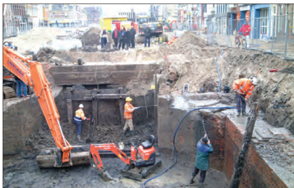
Afb. 18. Damsterdiep, blootleggen van de vroeg-19e-eeuwse sluisdeuren, gezien vanuit het zuidwesten. Foto: Jaap Buist, collectie Dienst RO/EZ.
