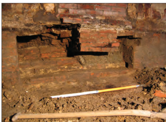
Afb. 25. Gelkingestraat 46-48, aanzicht van de oorspronkelijke entree in de zuidwand. De half weggebroken steen aan de rechterzijde van de trapopgang is een roodzandstenen duimblokje. Foto: Anko Wieringa, collectie ARC bv.
