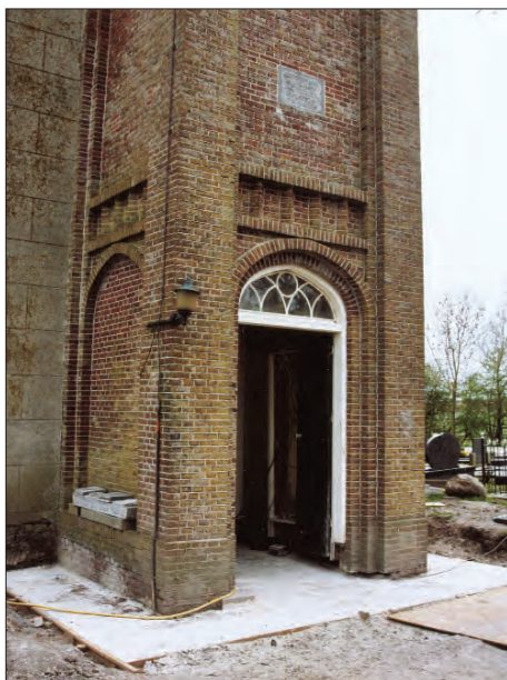
Afb. 7. Hoogeweg 4/Zijlvesterweg 16, Hervormde kerk te Dorkwerd, de onder kerk en toren aangebrachte nieuwe betonconstructie. Foto: Taco Tel, collectie Dienst RO/EZ.
