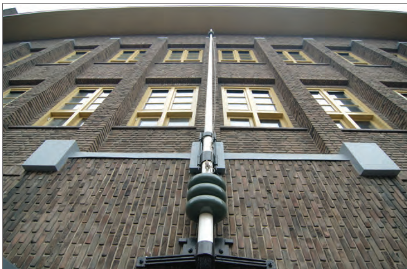
Afb. 30. W.A. Scholtenstraat 10, voorgevel na kleurherstel. Foto: Artès bureau voor architectuur en interieur.
