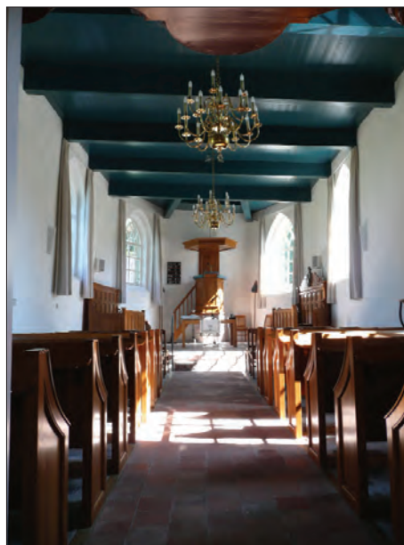
Afb. 8. Hoogeweg 4/Zijlvesterweg 16, Hervormde kerk te Dorkwerd, interieur na de herstelwerkzaamheden. Foto: Taco Tel, collectie Dienst RO/EZ.
